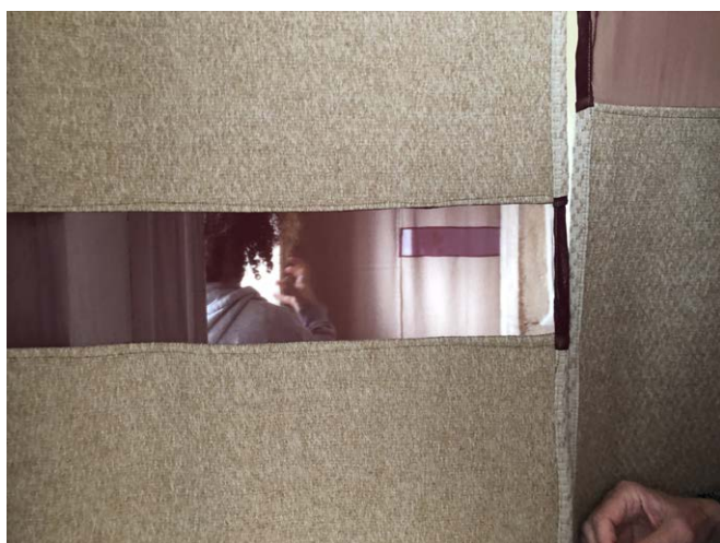
Détail du rideau d'entrée avec bandes translucides à deux hauteurs pour éviter les collisions.
