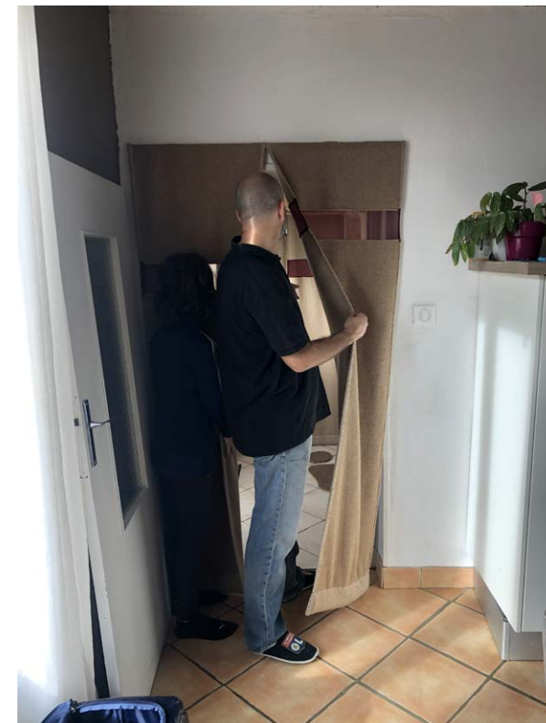
Rideau d'entrée installé entre l'entrée et le salon, vue depuis le salon. Une fente permet le passage tout en maintenant l'isolation.
