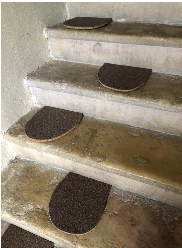
▲ Galets en liège installés dans l'escalier intérieur en pierre de la maison de la famille hiver 1. Aménagements organo-climatiques originaux, acceptés pour l'expérimentation car n'abîmant pas la pierre et respectant l'esprit et l'histoire de la maison vigneronne.
