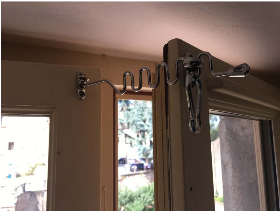
Entrebâilleur de fenêtre installé au 2 e étage dans une des chambres d'enfant.
